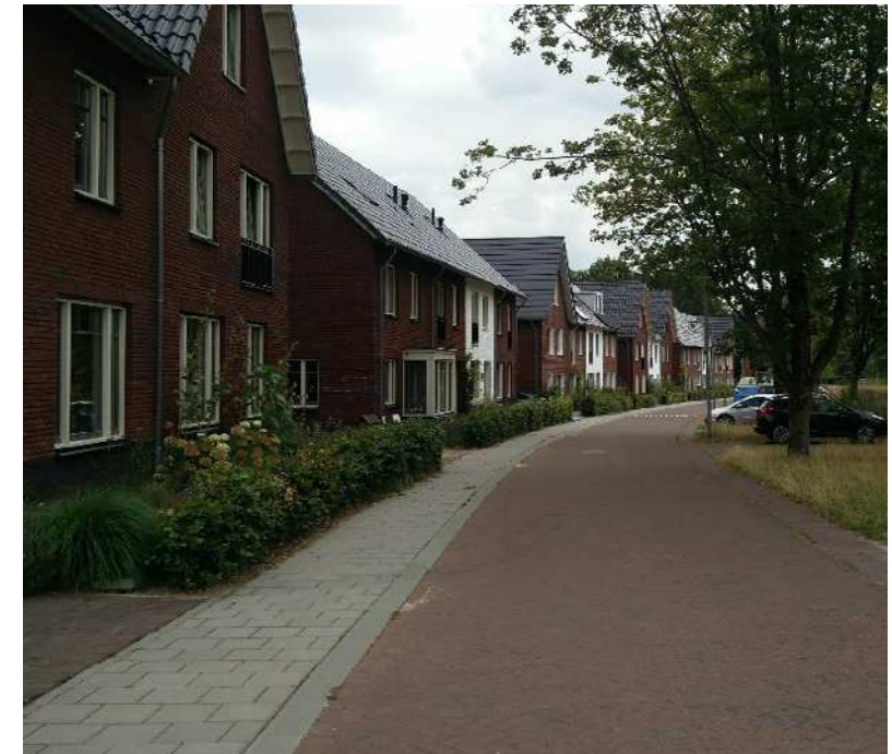
Straat met klinkers, trottoir ligt iets hoger
