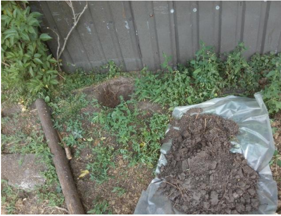
foto 1: Asbestinspectiegat deellootatie A: Veldschuur
