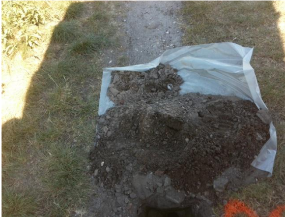
foto 7: Asbestinspectiegat deellocatie B: Vierendeelstraat en toegangsweg veldschuur
