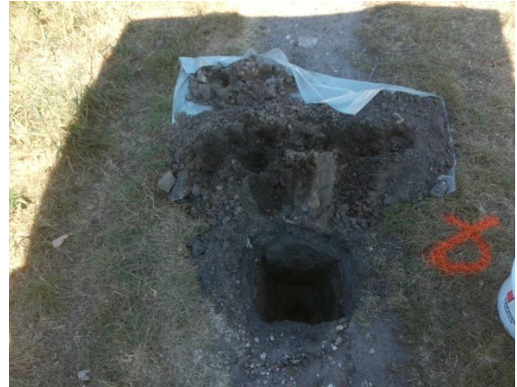
foto 8: Asbestinspectiegat deellocatie B: Vierendeelstraat en toegangsweg veldschuur
