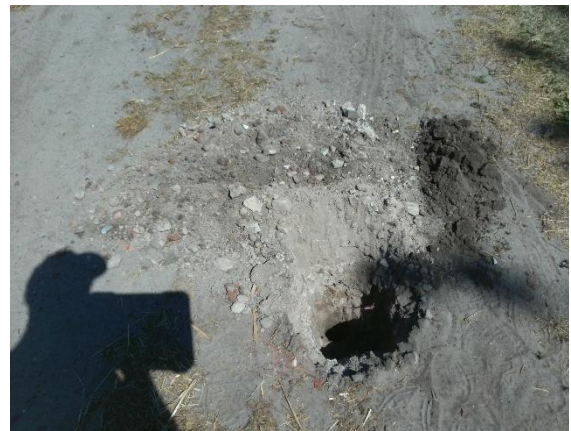
foto 10: Asbestinspectiegat deellocatie B: Vierendeelstraat en toegangsweg veldschuur
