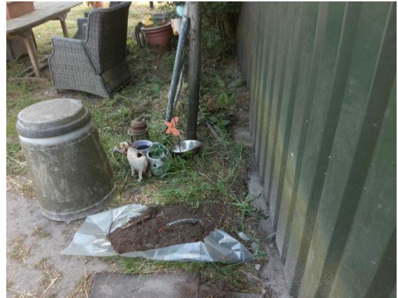
foto 4: Asbestinspectiegat deellootatie A: Veldschuur
