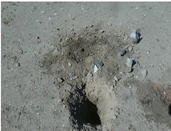
foto 9: Asbestinspectiegat deellocatie B: Vierendeelstraat en toegangsweg veldschuur
