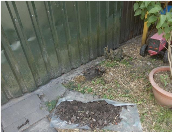
foto 3: Asbestinspectiegat deellootatie A: Veldschuur
