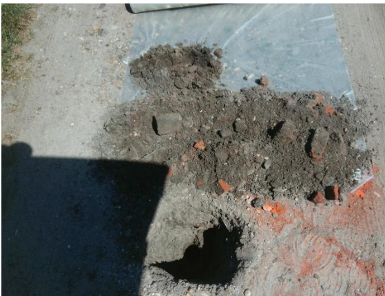
foto 5: Asbestinspectiegat deellootatie B: Vierendeelstraat en toegangsweg veldschuur
