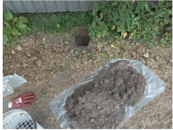
foto 2: Asbestinspectiegat deellootatie A: Veldschuur
