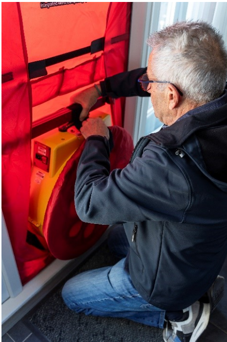
Figuur 1 Lekchecker installeert de blowerdoor in de buitendeur (foto: Angelique van den Boer Fotografie)
